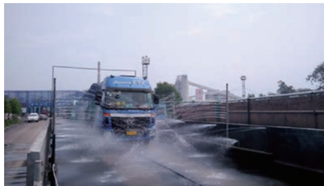
冲车台冲洗运煤车辆
